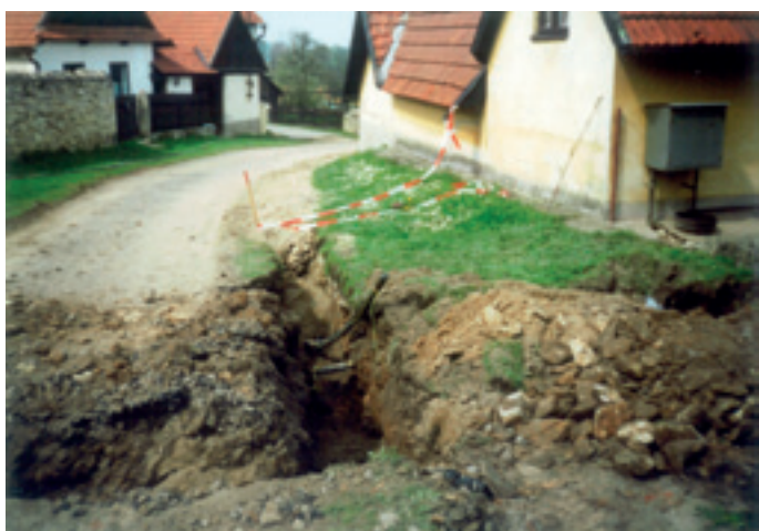
Pokládka středotlakového potrubí na Vísece.
