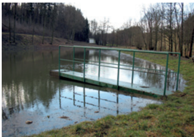
Současný stav po rozšíření - 2015.
