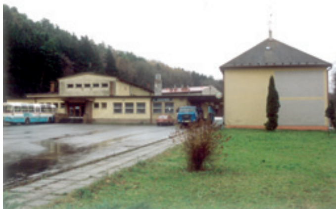
Kulturní dům před provedením nástavby.
