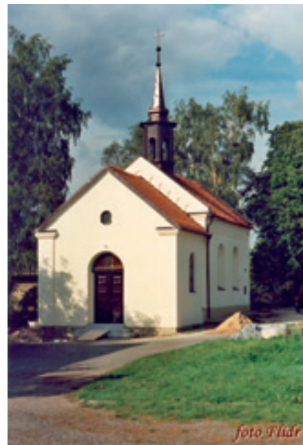
Kaple po dokončení přístavby.
