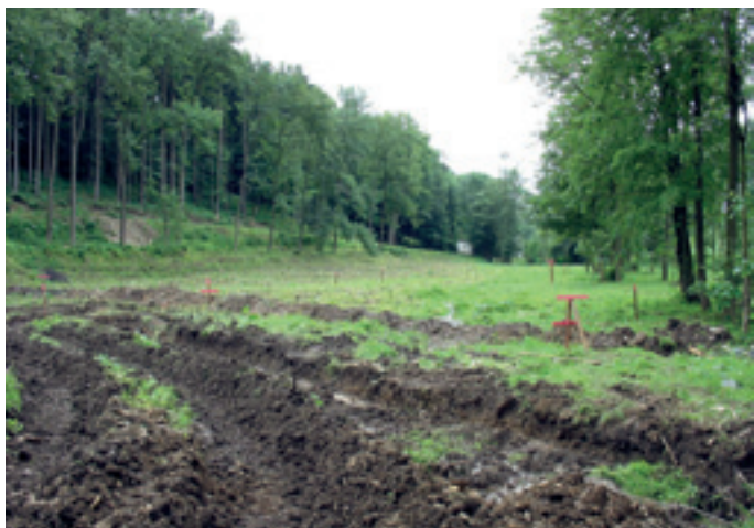
Vytyčení tělesa hráze.
