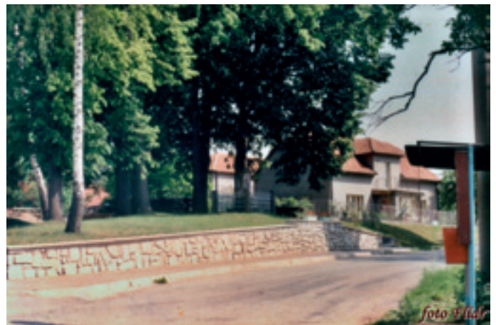
Dokončená opěrná zeď.
