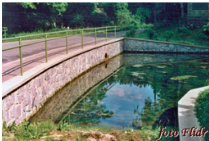
Dokončená opěrná zeď.
