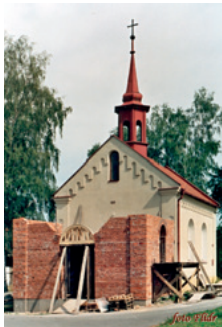
Průběh realizace přístavby kaple.
