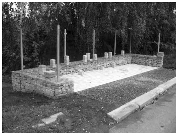
Výstavba nového stání na Krásňovsi, které bude rozšířeno o jeden kontejner. Foto: ing. R. Boštík
